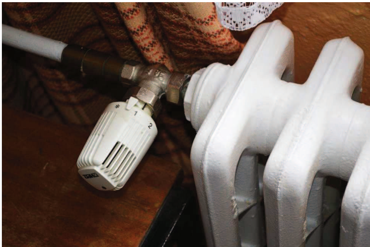
Otopné těleso s termostatickou hlaví
