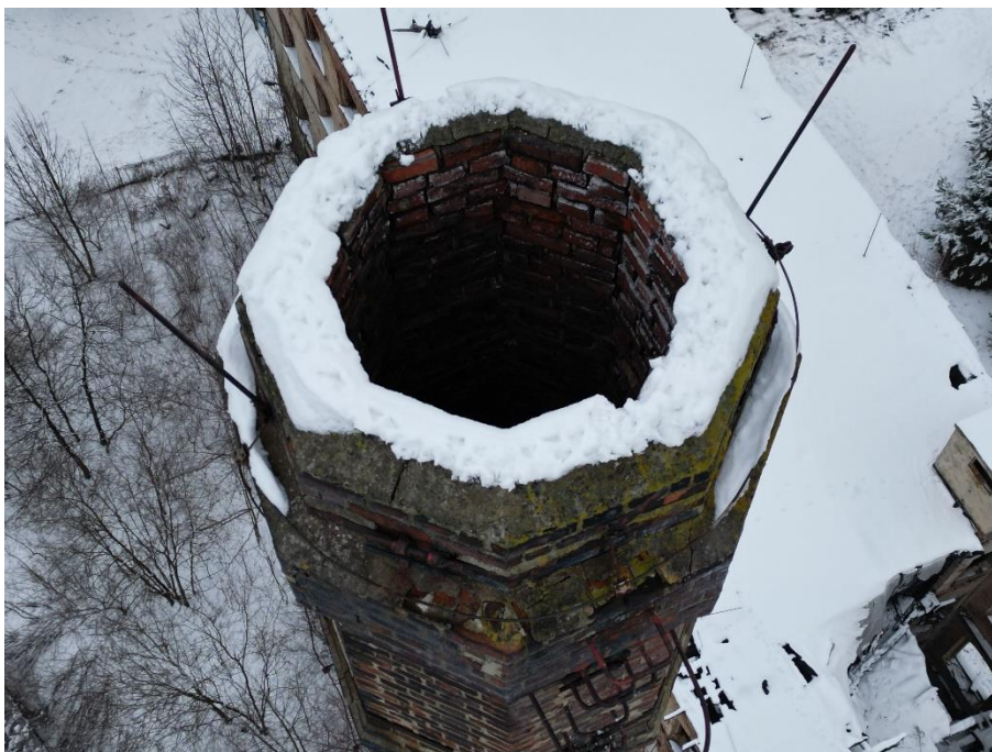
Pod korunou komína je rozšířená hlava výšky cca 0,45 m, tloušťka zdiva je zde 450 mm.
