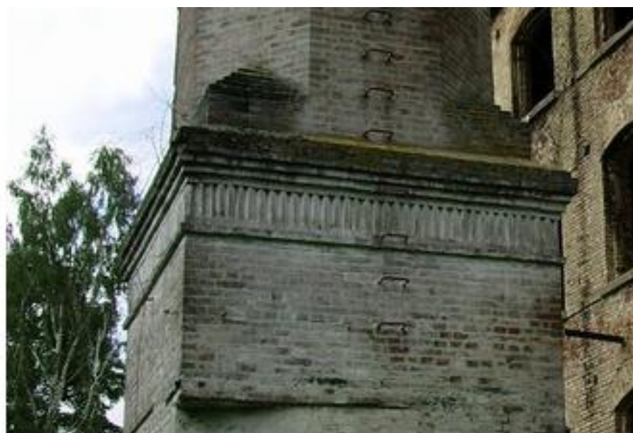
Horní osmiboká část komína má proměnlivou tloušťku zdiva, ve spodní části je tl. cca 900 mm, zdivo se pravidelně ztenčuje o 150 mm, takže v koruně má tl. 300 mm. Ukončení komína je betonovou mazaninou ve spádu.
