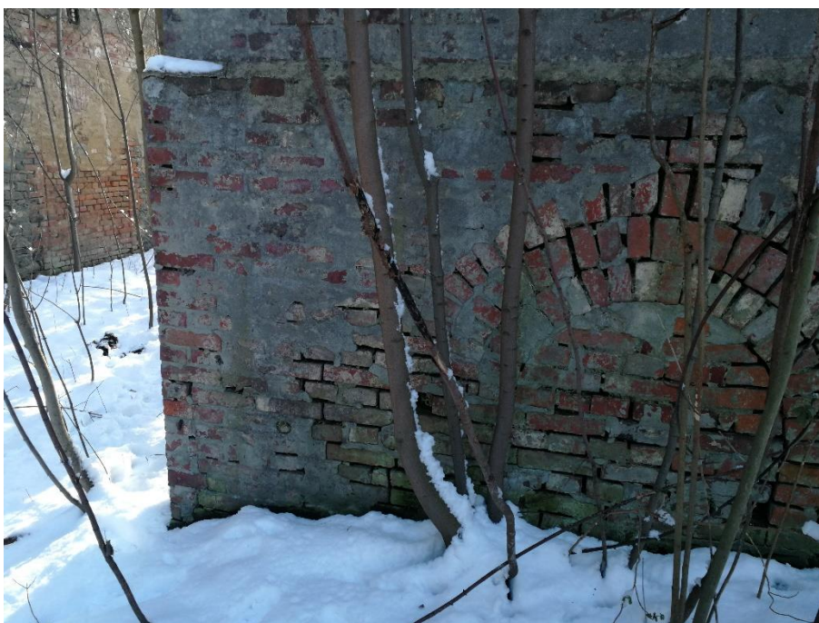
Čtvercová základna je ukončena přečnělkovou římsou s náběhy. Horní hrana římsy je opatřena spádovou betonovou mazaninou.
