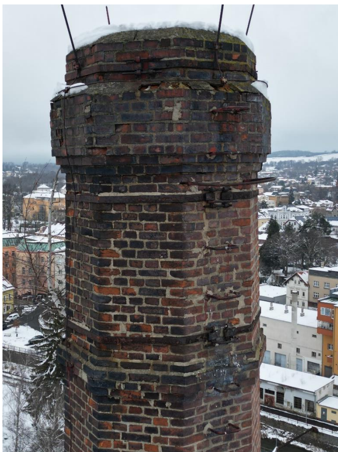
Pod korunou komína je rozšířená hlava výšky cca 0,45 m, tloušťka zdiva je zde 450 mm.
